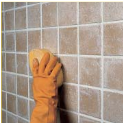
Fugakép kialakítása tisztítószivaccsal
