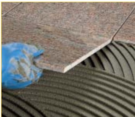
Burkolat fektetése ragasztóhabarcsba
