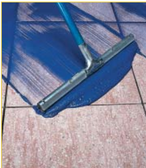
A fugázóhabarcs bedolgozása a padlóburkolat hézagaiba
