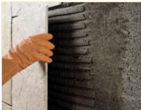
Nagyformátumú greslap ragasztása
