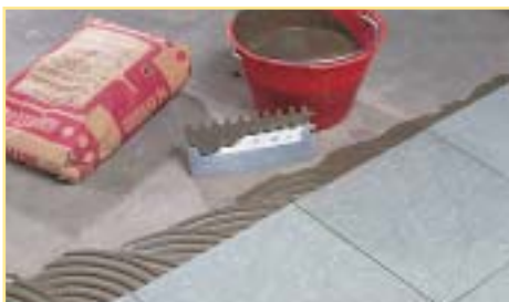
A ragasztót fogazott simítóval hordjuk fel
