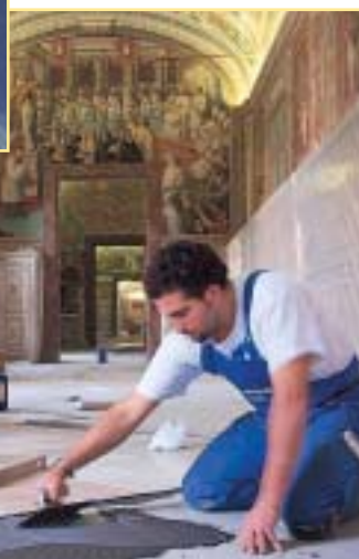
Gresporcelán burkolat fektetése fugakereszt használatával
