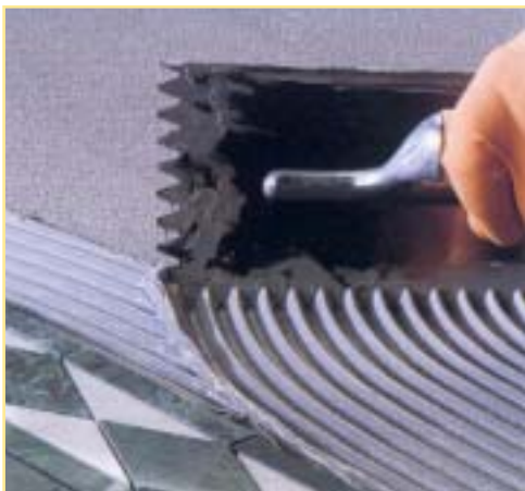
Természetes kő ragasztása poliuretán ragasztóval
