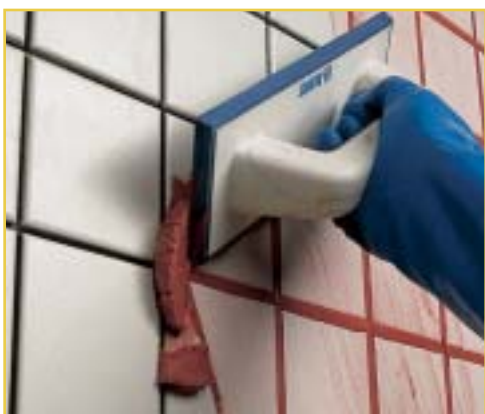
A fugagumi biztosítja a fugák megfelelő telítettségét
