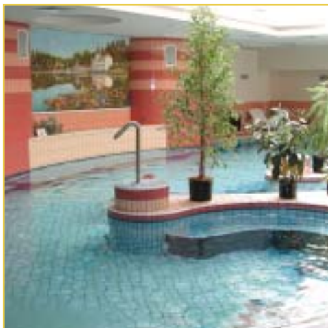
KERAPOXY-val fugázott üvegmozaik burkolat
