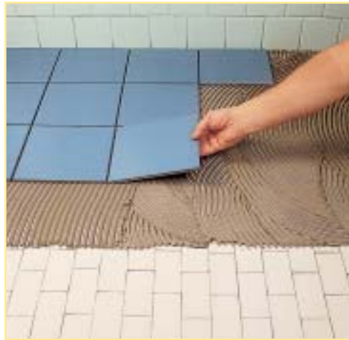
A nyitott idő lejártá előtt rakjuk le a burkolatot
