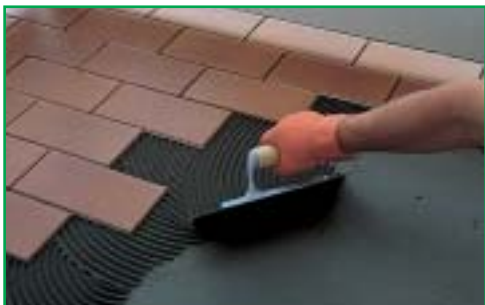
MAPELASTIC-kal szigetelt erkély burkolása
