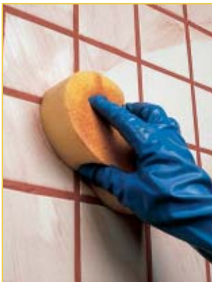
A fugázás utolsó fázisa a burkolat tisztára törlése fugázó szivaccsal
