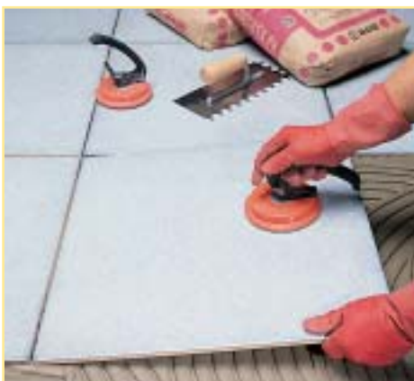
A fogazott simító mérete a lap méretétől is függ
