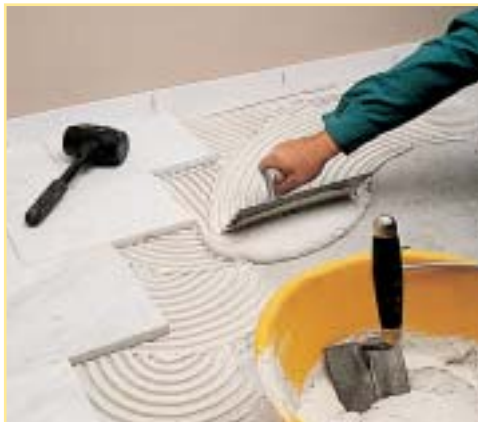
Márványburkolat ragasztása fehér GRANIRAPID-dal
