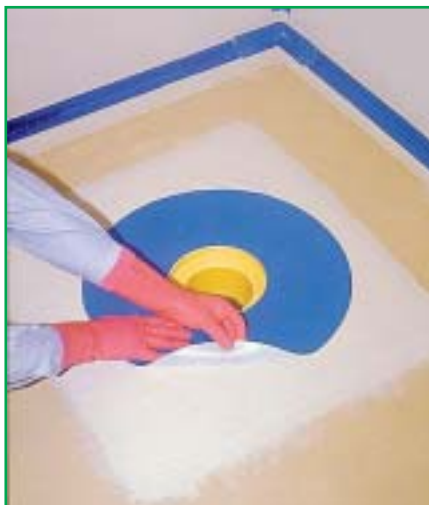
MAPEBAND szalaggal fektetése
