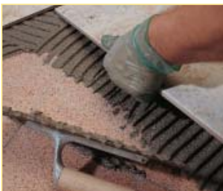
A fogazott simító mérete a lap méretétől is függ
