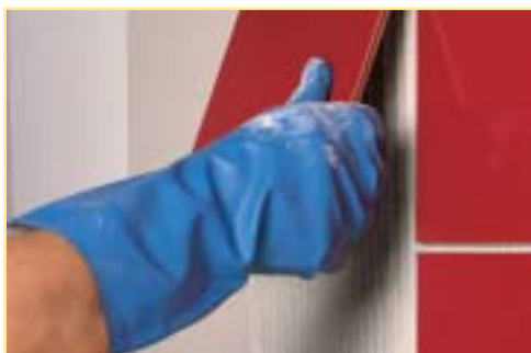
Oldalfali burkolat készítése
