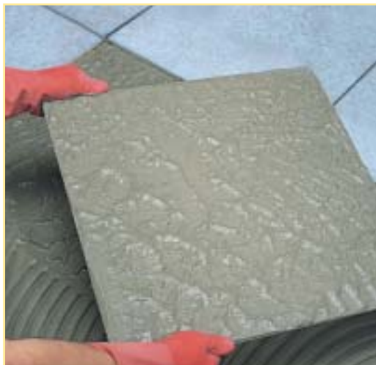
Kültérben kétoldalas ragasztást vagy folyóágyas ragasztót alkalmazunk
