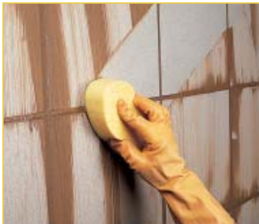
Fugázóanyag lemosása szivaccsal
