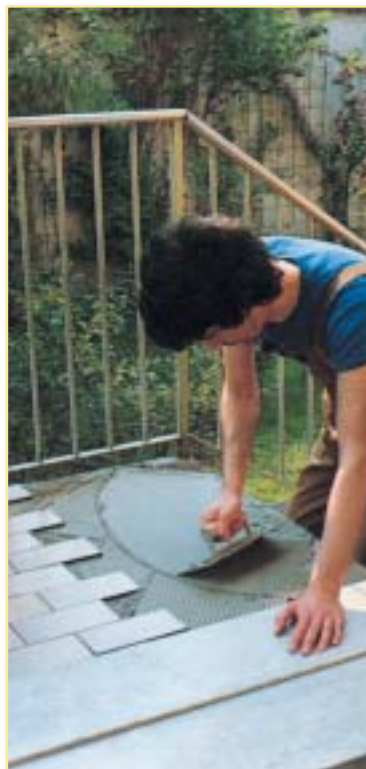
Kültéri burkolat ragasztása flexibilis ragasztóhabarccsal
