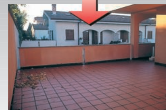
Terasz vízszigetelése Mapelastic-kal a régi padlóburkolat felújítása nélkül
