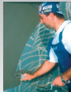
Meglévő, textúrált vakolat simítása Planitop 200-zal
